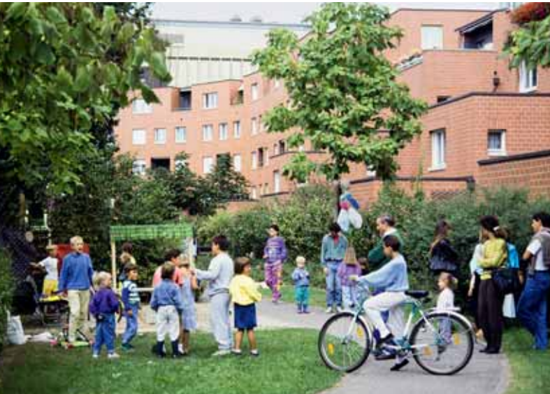
5 Zurück in die Stadt: Der Bau am Lommisweg von 1985 ist gegen aussen ein kompakter Schutzwall gegen den Strassenlärm, im Hof liegen ein ruhiger Aussenraum und private Terrassen.
